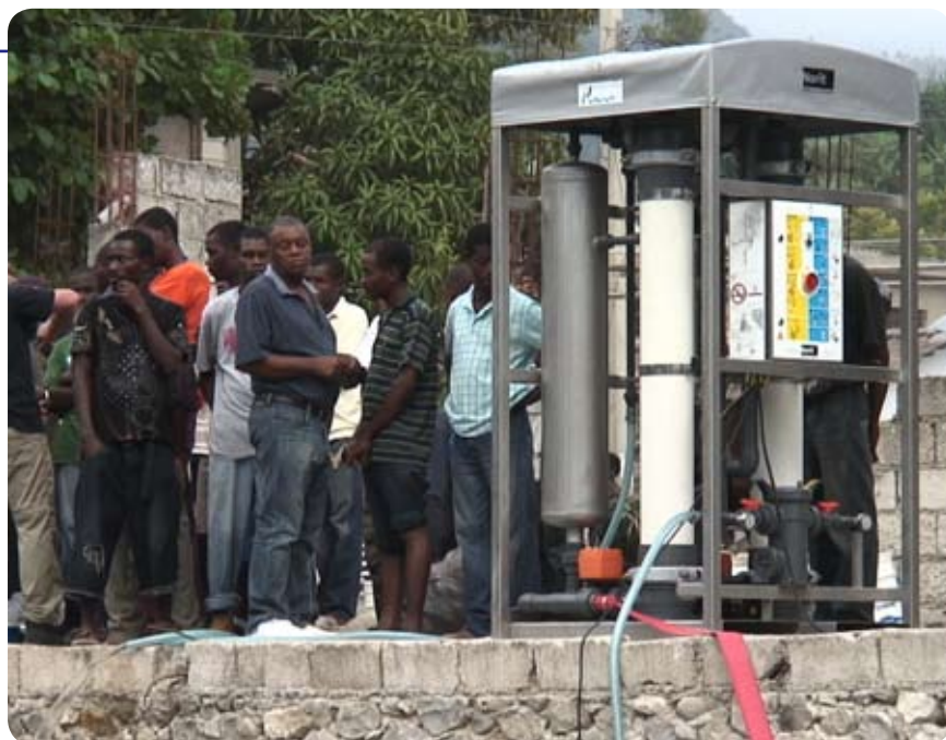
De plaatsing van een waterzuiveringsinstallatie in een van de zwaarst getroffen gebieden in Port-au-Prince.
